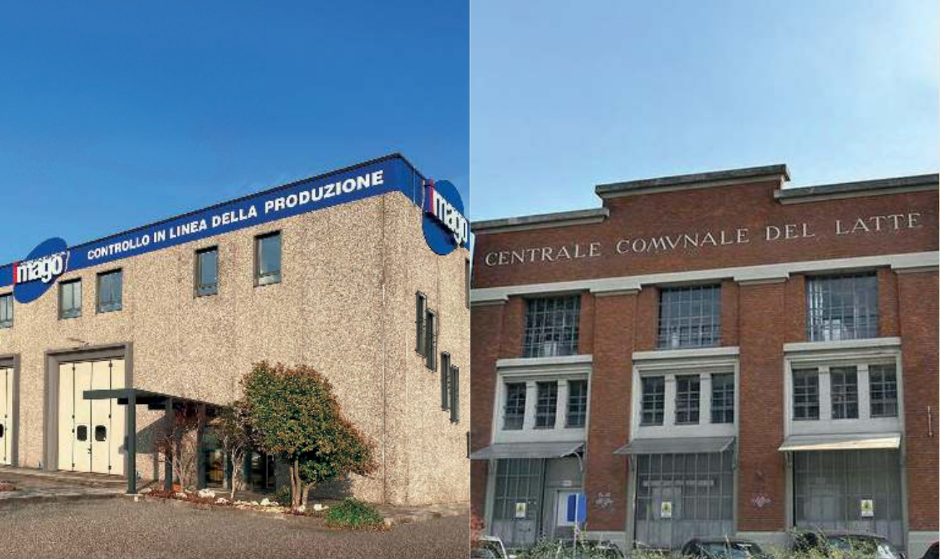
Stabilimenti. Le sedi di Imago e di Centrale del Latte
